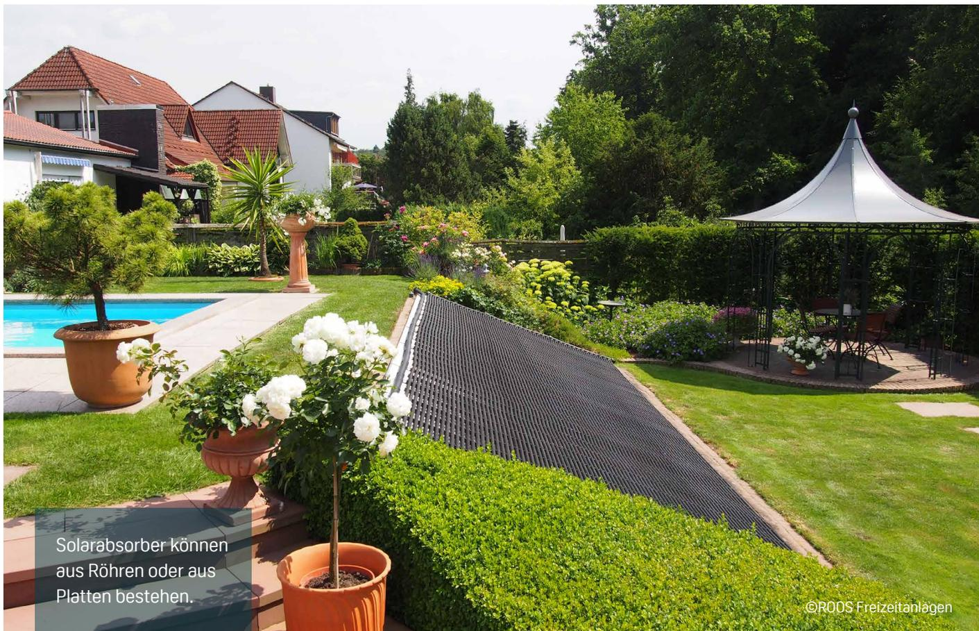
Leitungswege kurz und Wärmeverluste gering halten. Selbst an bedeckten Tagen liefern die schwarzen Matten einen erheblichen Wärmegewinn ans Beckenwasser. Über Auslegung, Position und Einbindung in den Wasserkreislauf weiß der Schwimmbadexperte Bescheid.
